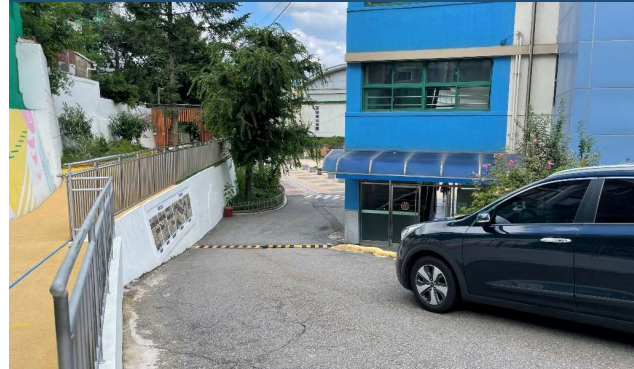
4. 주차장 출입구 (출구방향)
